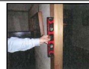
水平器による柱の傾きの計測
