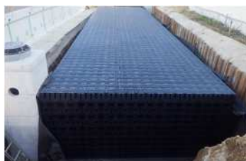
地下型貯留浸透槽
