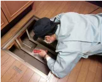
「土台・床組、基礎」調査の様子
