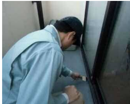
「外部（バルコニー）」調査の様子
