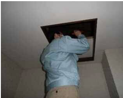
「小屋組・梁」調査の様子
