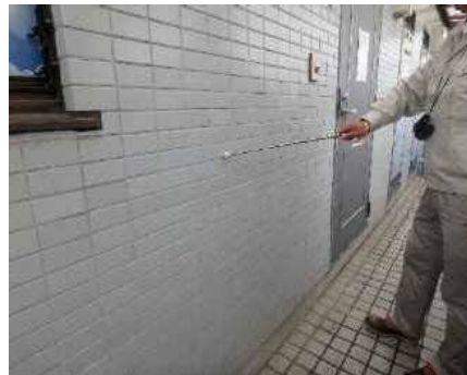
「外部（外壁）」調査の様子
